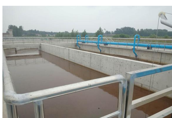
图 4-6 细格栅及旋流沉砂池
