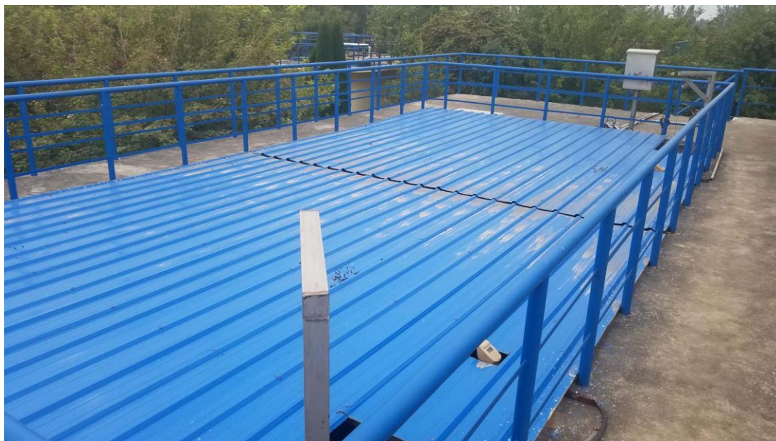
图 4-4 污泥池加盖密闭照片
