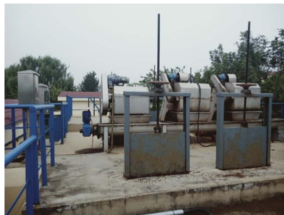
图 4-6 细格栅及旋流沉砂池
