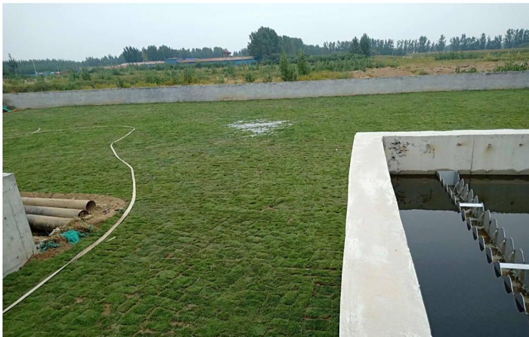
图 4-3 高效沉淀池西南和南侧绿化照片
