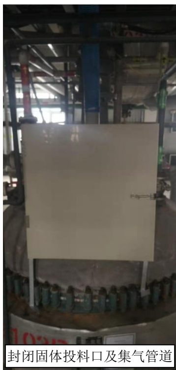
反应釜密闭投料及集气管线
