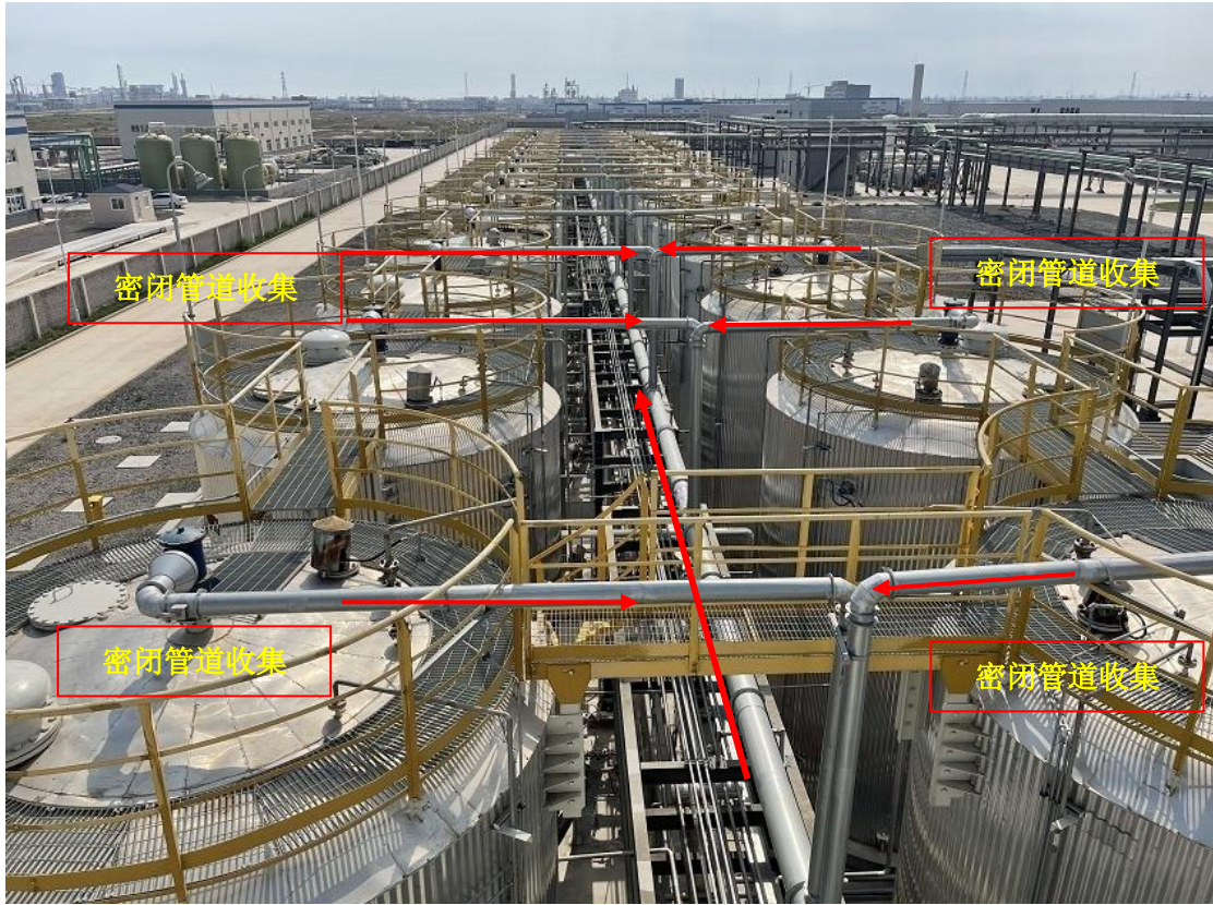
图 4.1-2 罐区废气收集方式示意图
