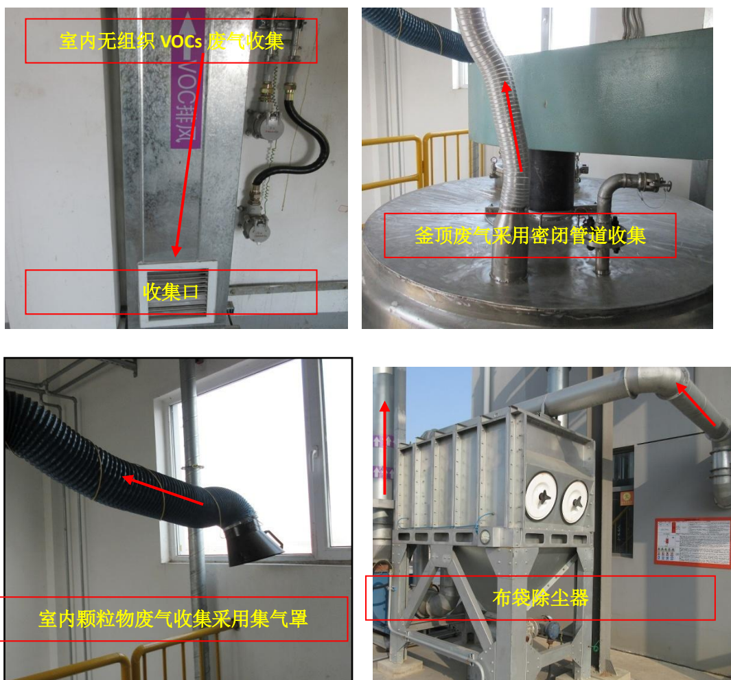
图 4.1-3 硝化纤维素车间废气收集方式及处理措施示意图
