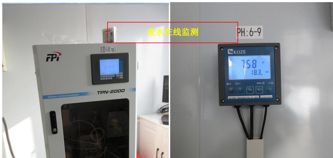
图 4.1-7 废水治理措施及在线监测示意图
