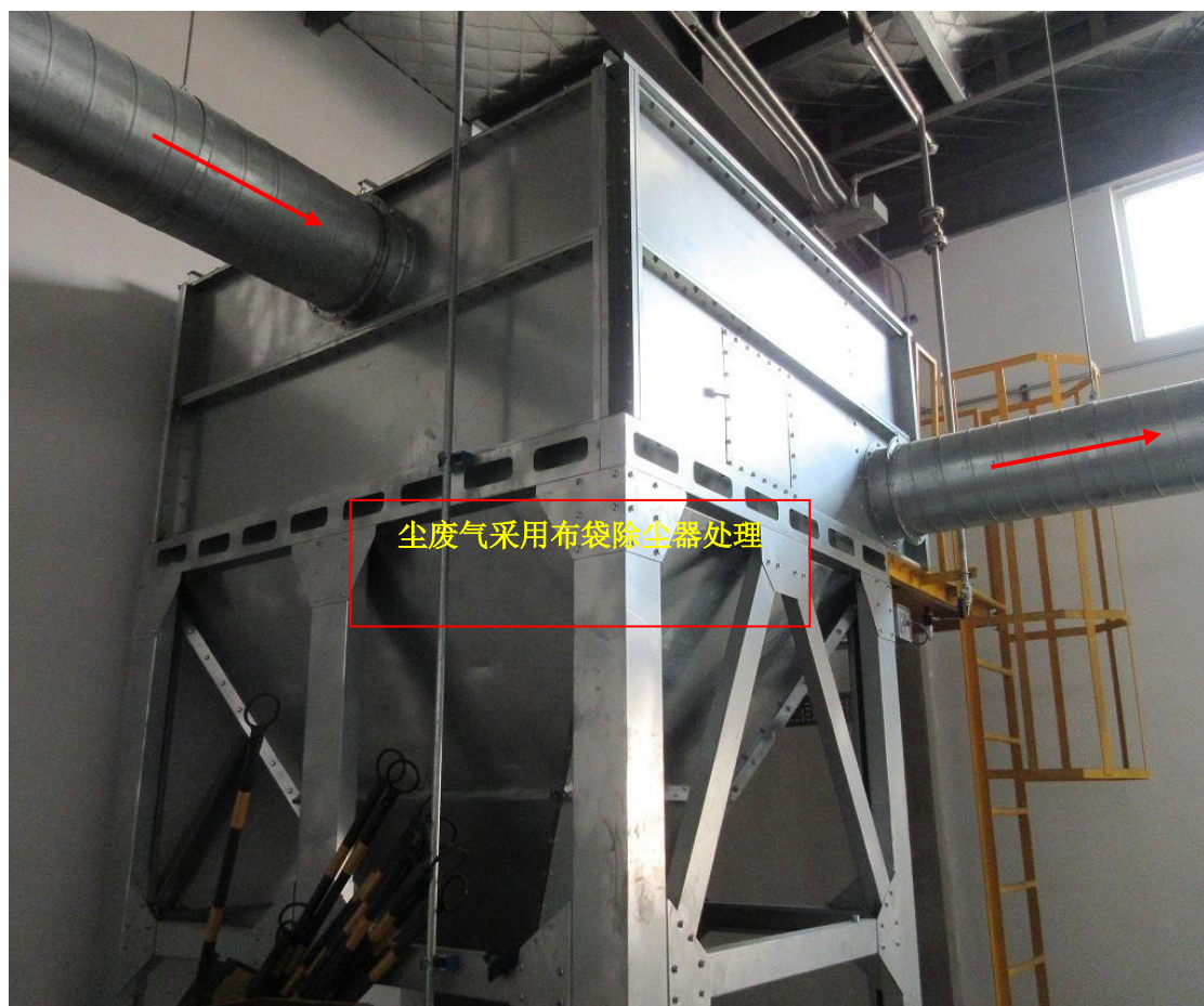
图 4.1-5 甲类车间废气收集方式及处理方式示意图
