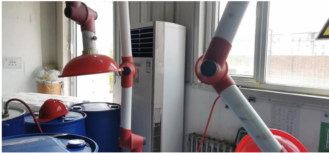
图 4.2-2 投加分子筛集气罩
