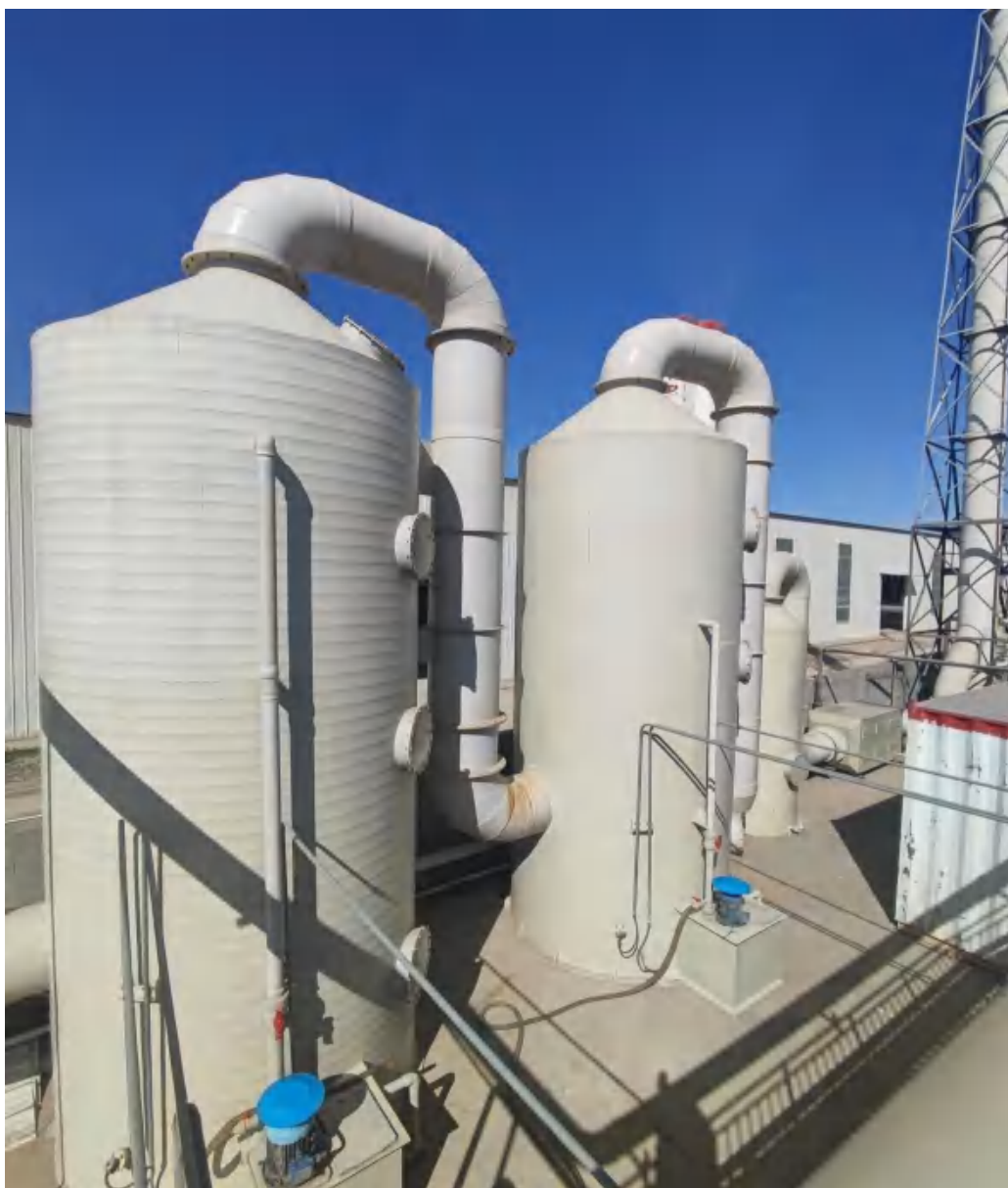
图 4.2-4 TA014 废气处理措施建设情况
