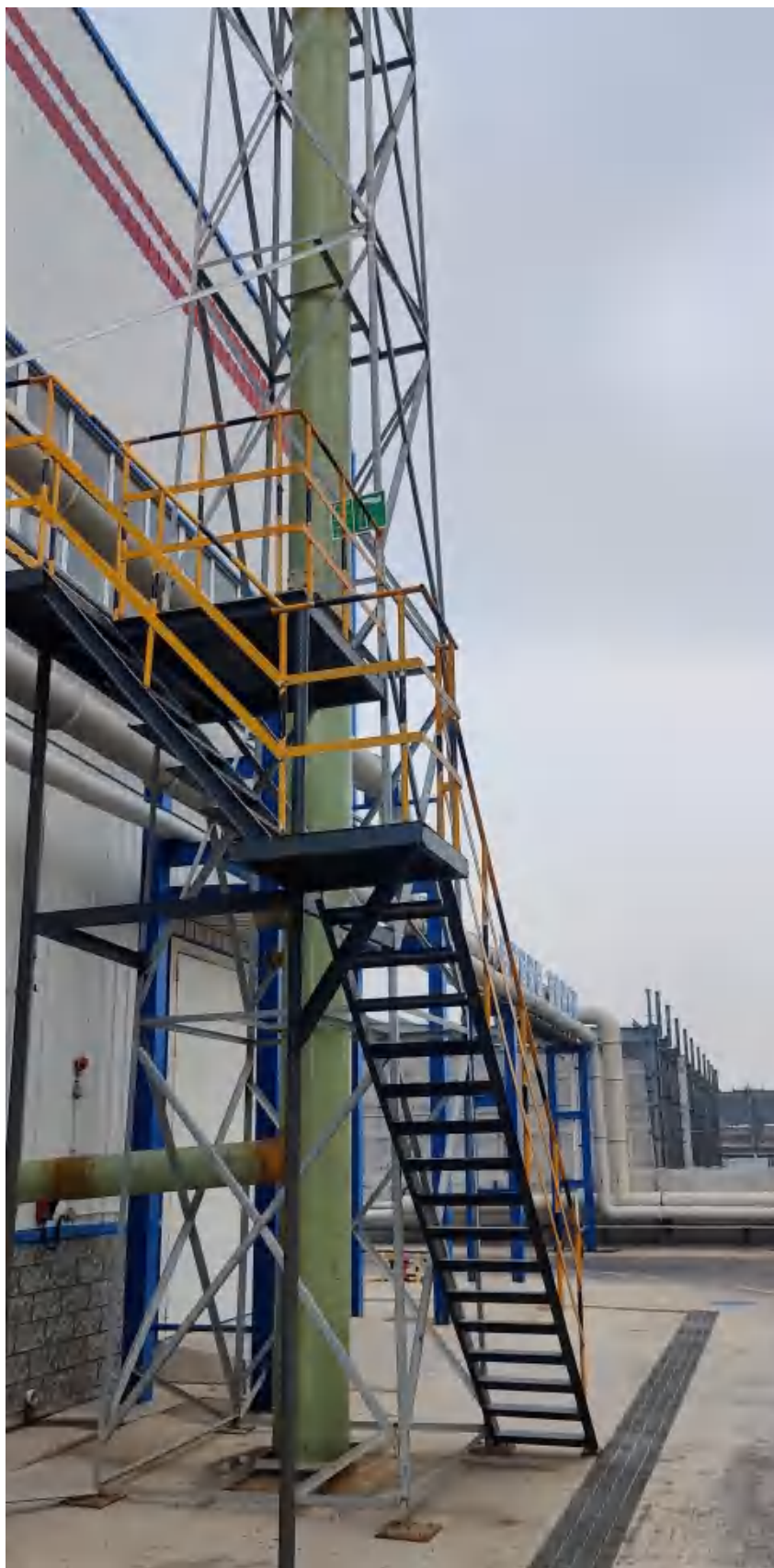
图 4.3-2 DA002 排气筒及采样平台
