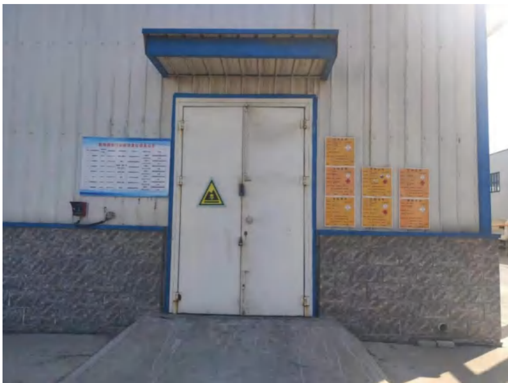
图 4.2-12 危废库建设情况
