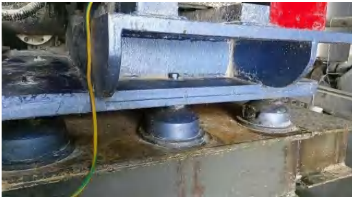
图 4.2-11 降噪措施实际建设情况
