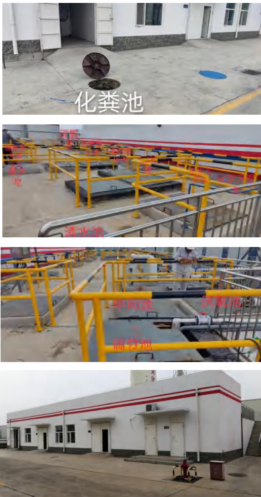
图 4.2-9 厂区污水处理设施实际建设情况
