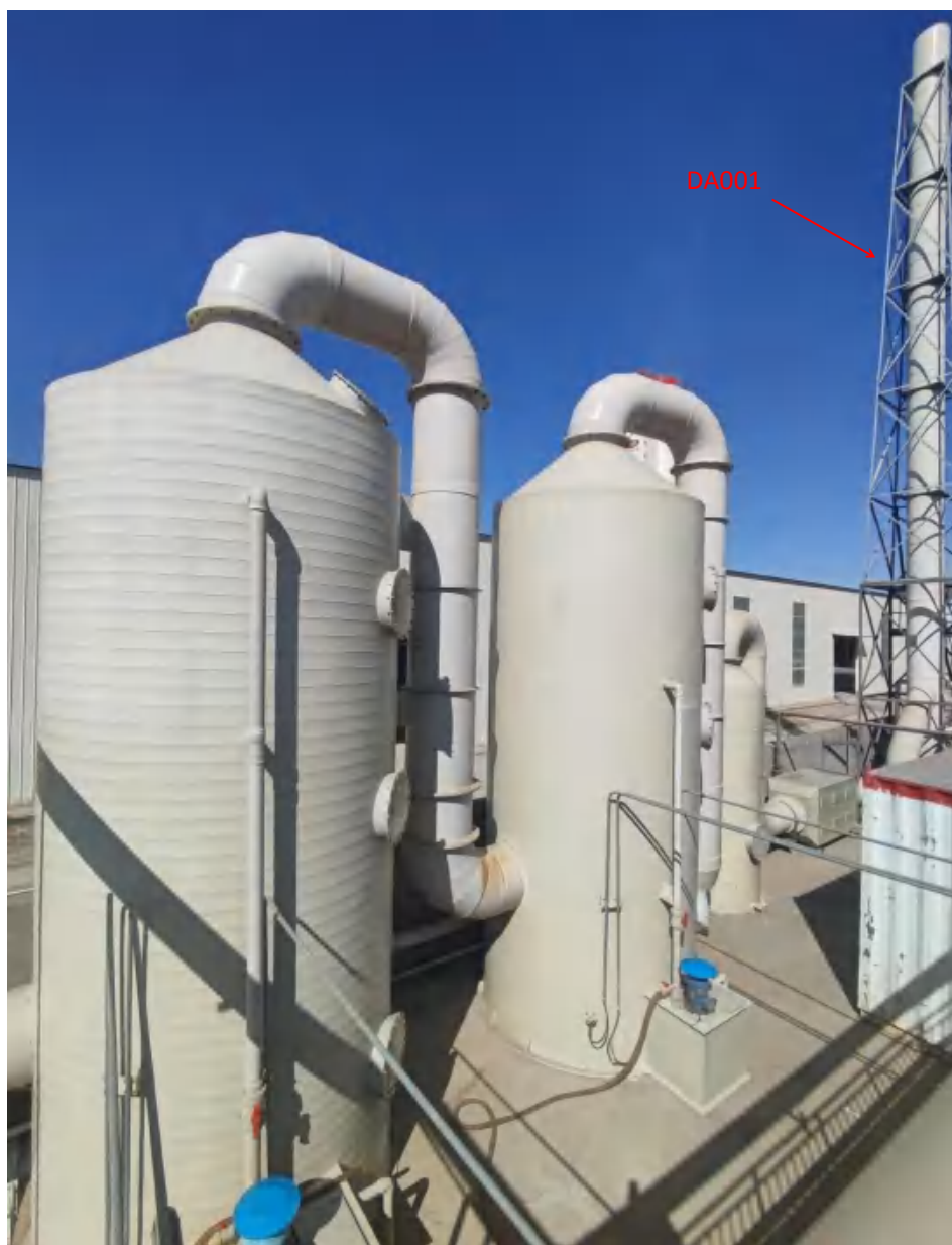
图 4.2-5 DA001 排气筒建设情况
