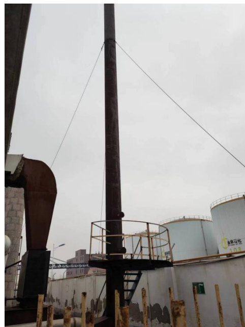
锅炉烟气除尘设施及排气筒
