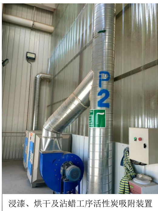
浸漆、烘干工序封闭操作间及集气措施
