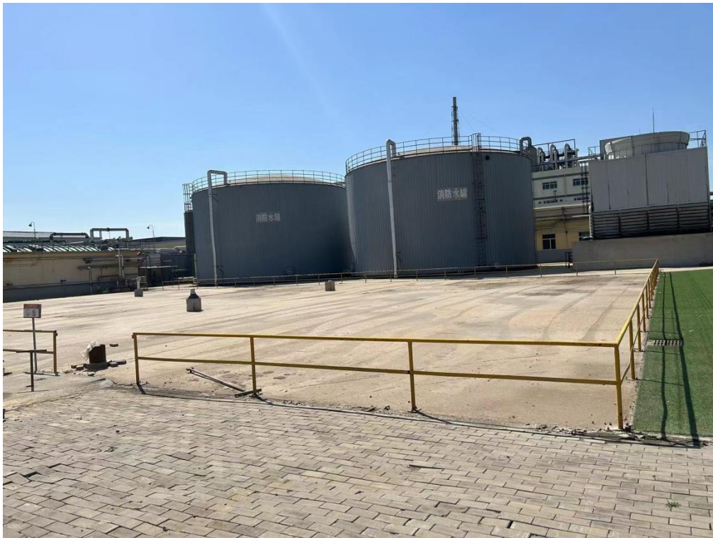
消防水罐及消防废水池（地下）
