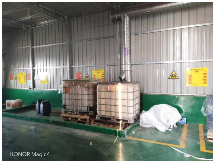
危废间内部建设情况
