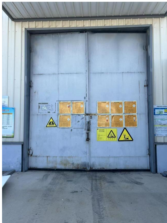
危废间外部照片
