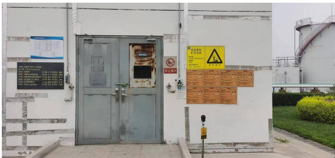
图 4.2-10 液体危废间外部
