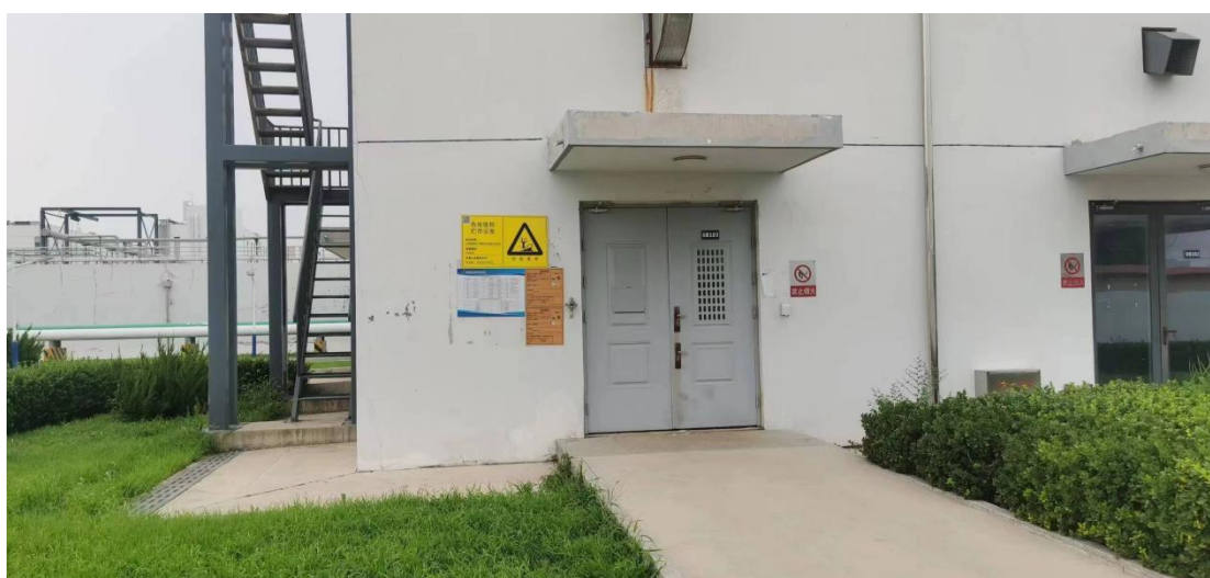
图 4.2-10 固体危废间外部
