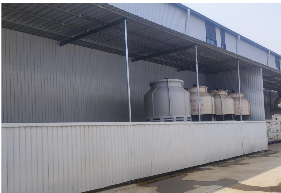
图 4.2-3 冷却循环系统建设情况
