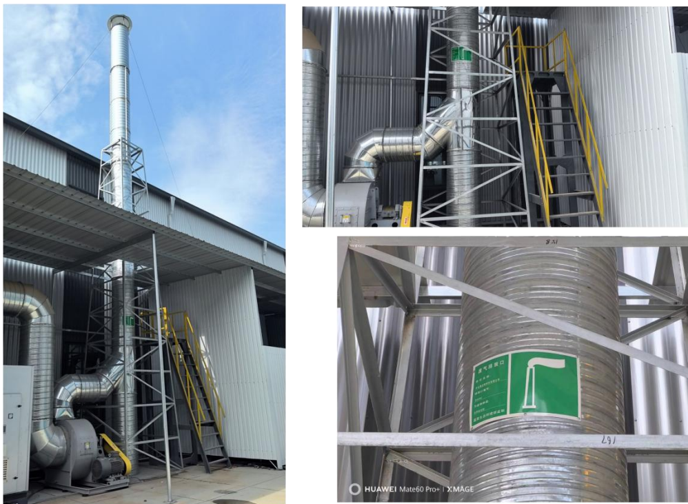
图 4.2-2 DA002 排气筒建设情况
