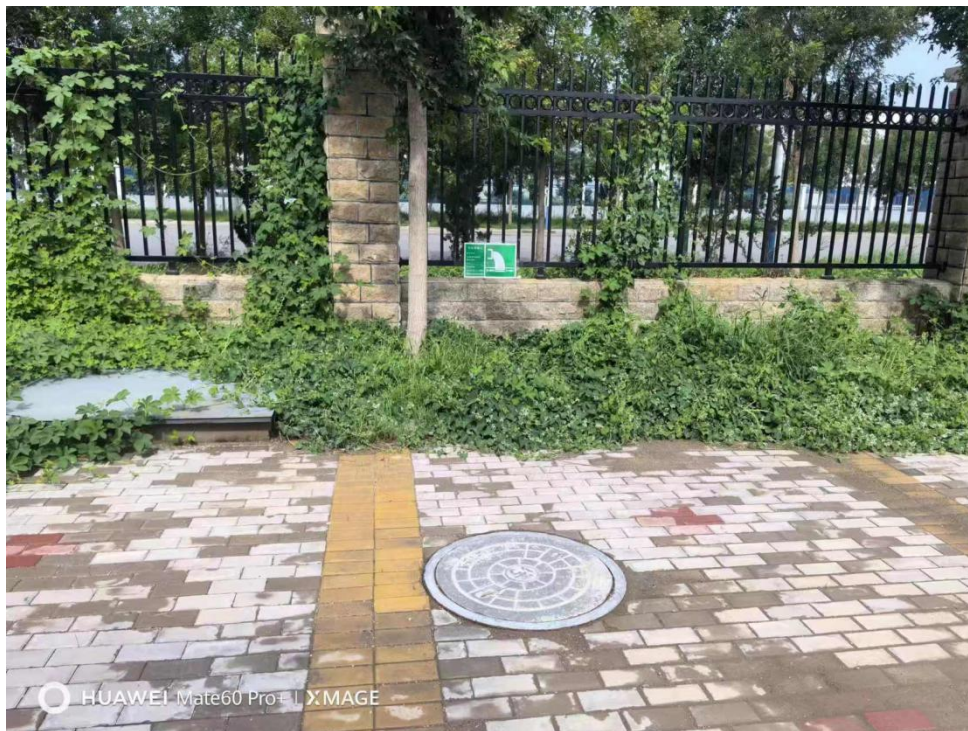
图 4.2-4 化粪池、DW001 废水排放口实际建设情况
