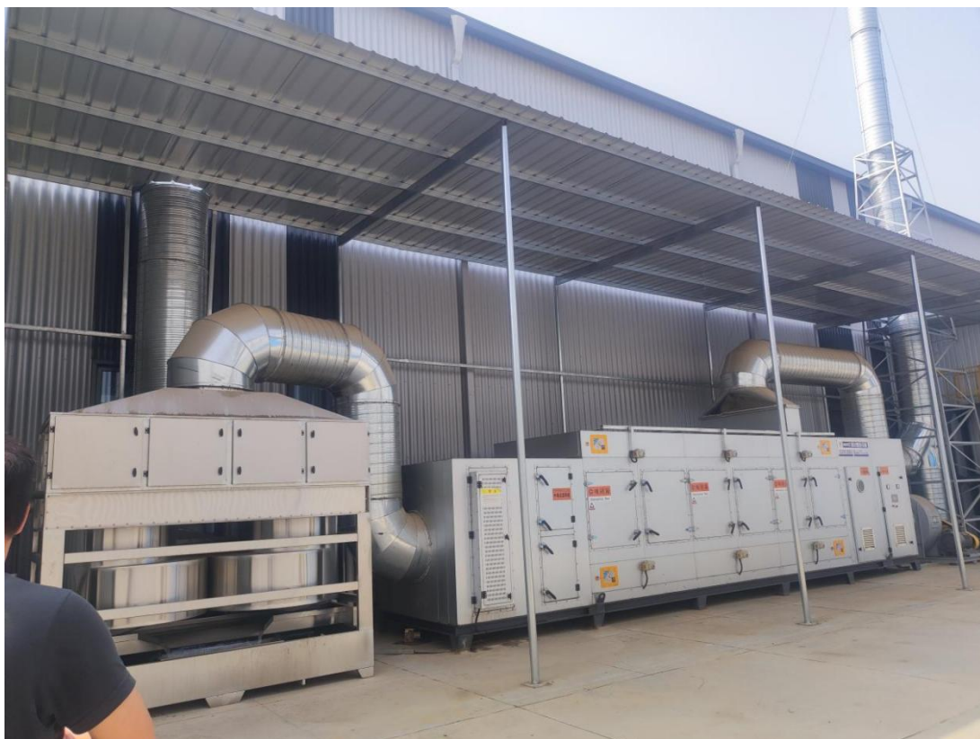
图 4.2-1 TA002 废气处理措施建设情况
