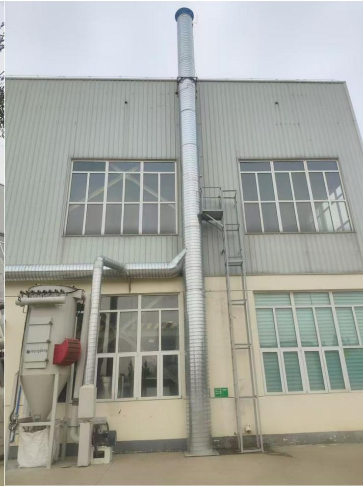
图 2.DA002 排气筒与脉冲除尘器
