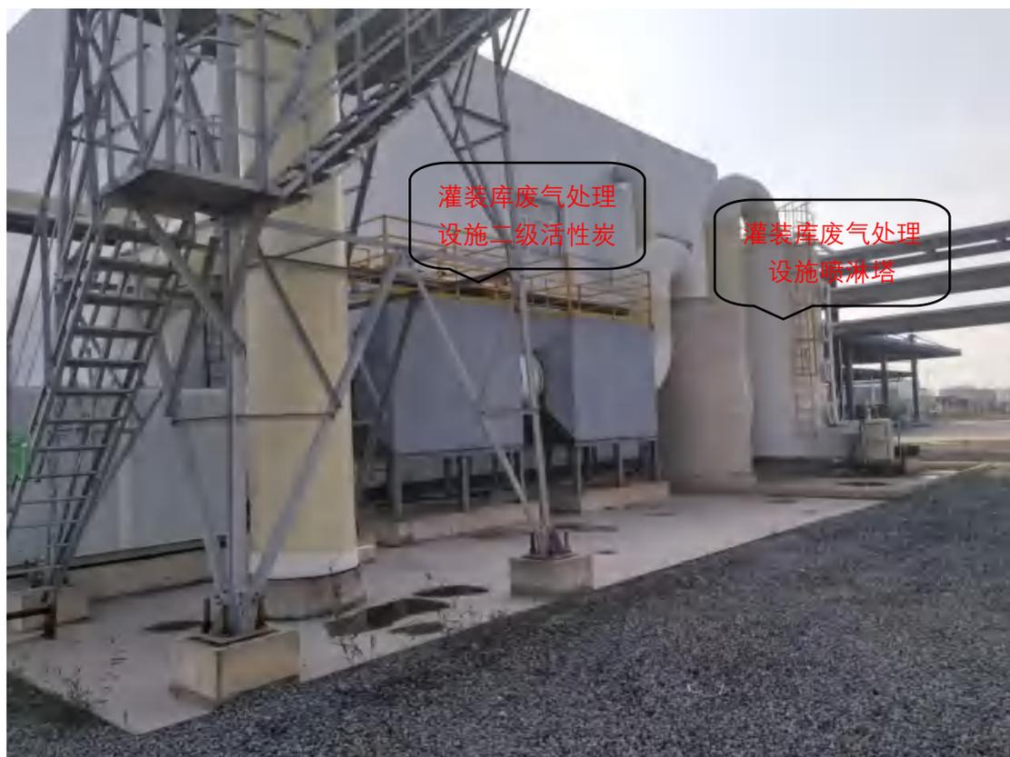
图 4.2-12 灌装库废气处理装置
