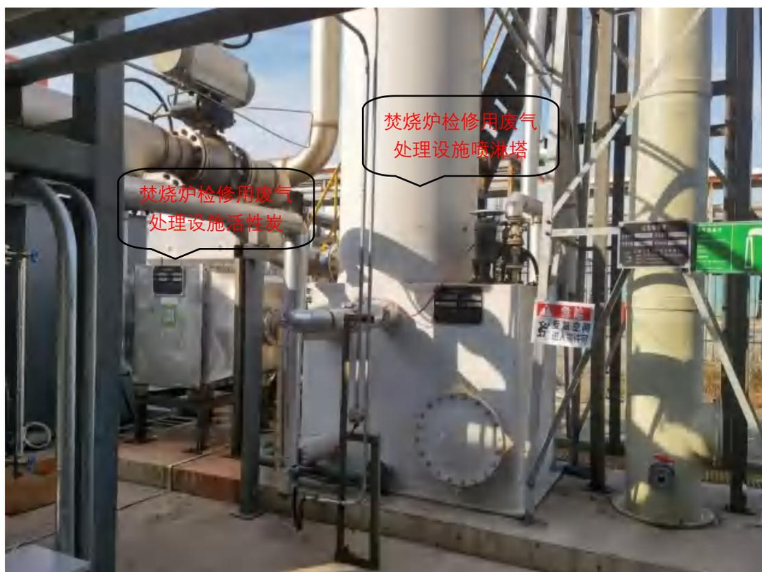
图 4.2-12 焚烧炉检修用废气处理设施
