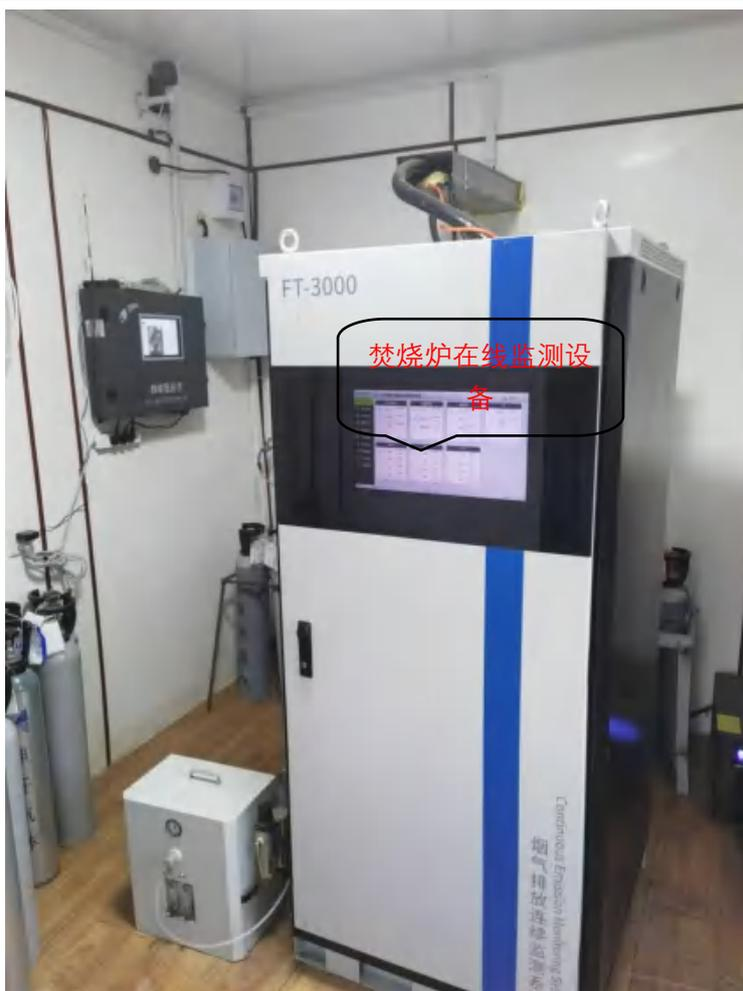
图 4.2.20 焚烧炉在线监测
