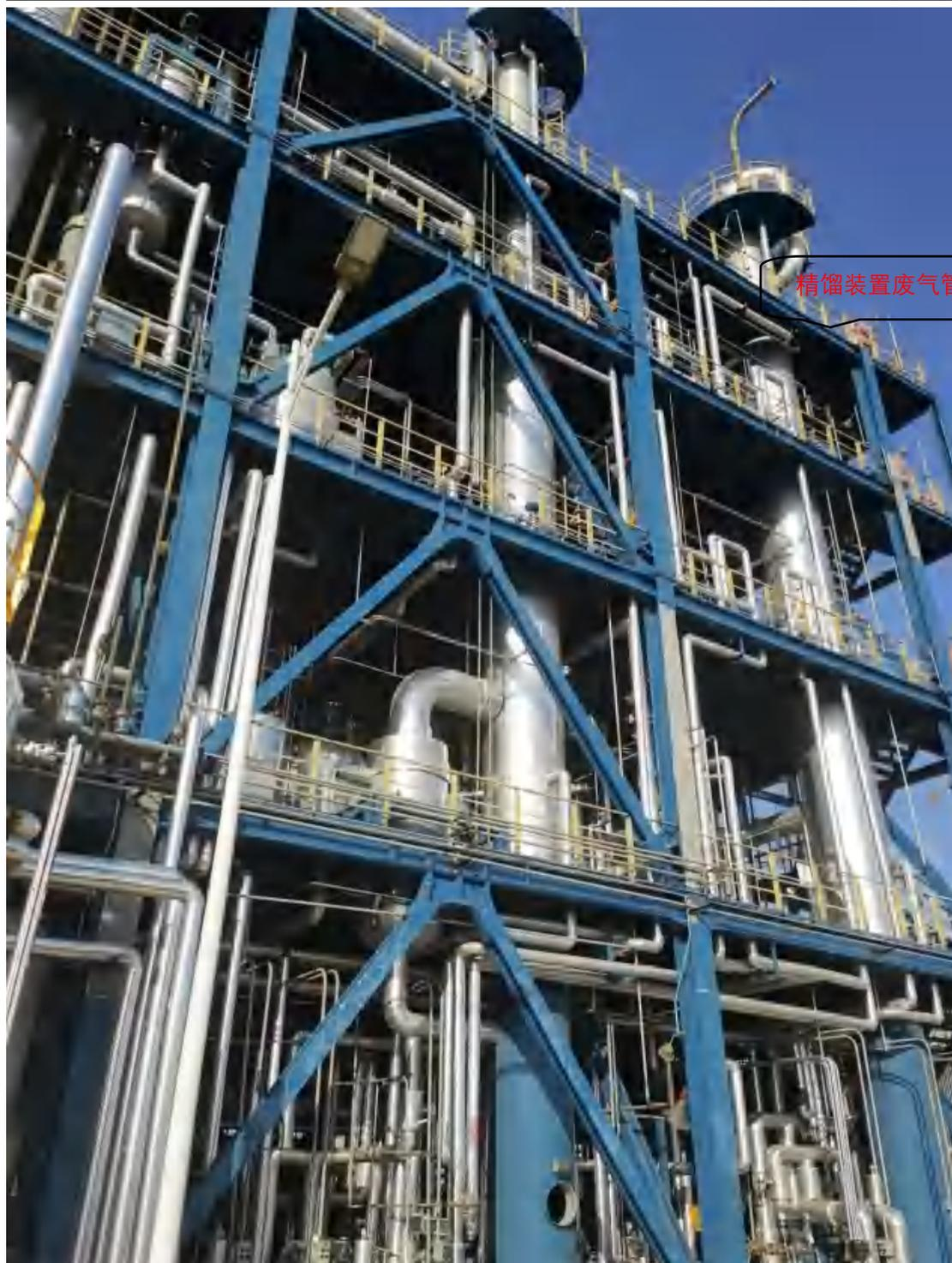
图 4.2-9 精馏装置废气收集管道
