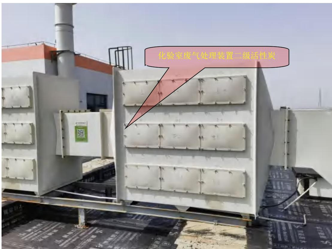
图 4.2-11 化验室废气处理装置
