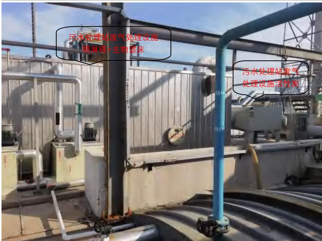
图 4.2-10 污水处理站废气处理装置
