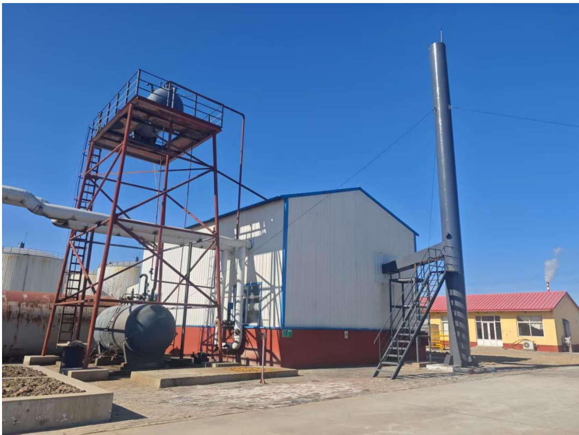
图 4.2-2 DA001 排气筒建设情况
